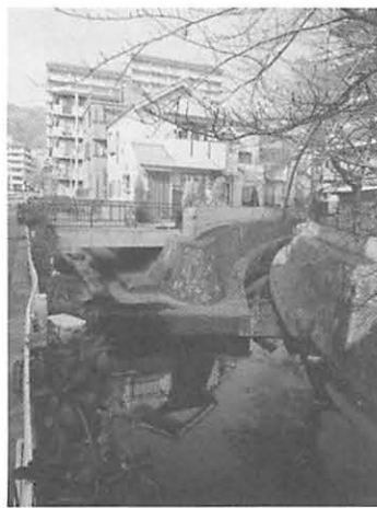
写真5 水路の合流地点
